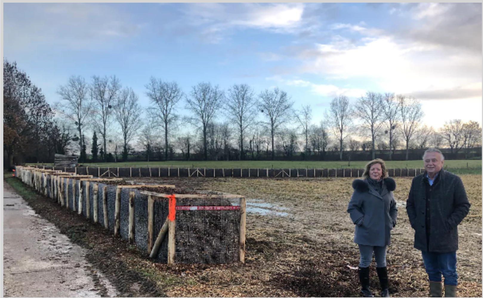
Aanleg van een erosiedam in Nerem (Tongeren)
