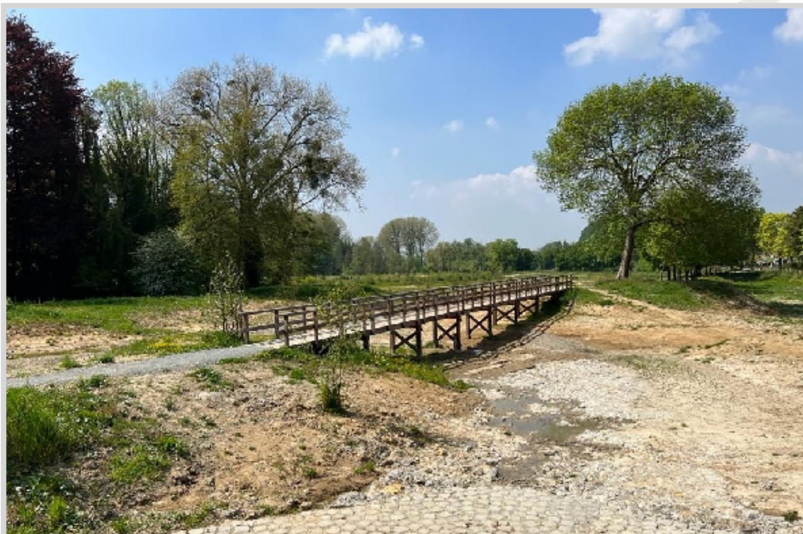
Werken aan de Bypass ter hoogte van Valkenburg. Beeld: Waterschap Limburg
