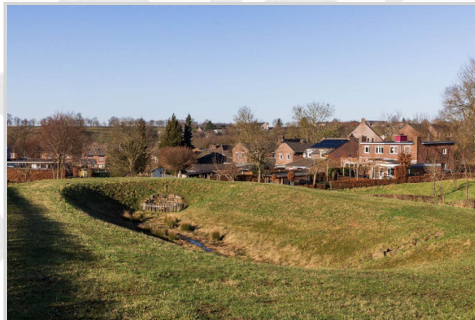
Aanleg van overstromingsgebieden in het Noordal in het kader van Liquid Commons. Beeld: Waterschap Limburg
