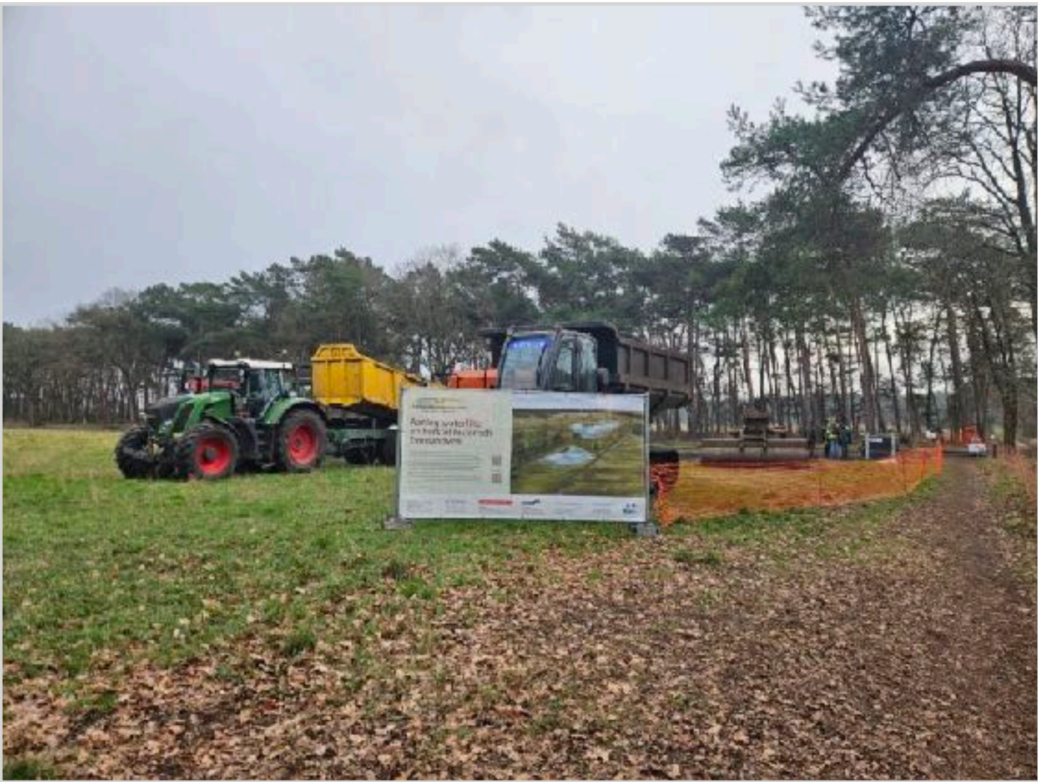
Aanleg filter in Steertse Heide Grenspark Kalmthoutse Heide
