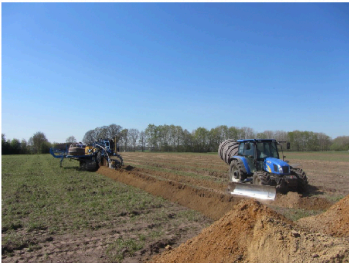
Het subirrigatiesysteem, bestaande uit infiltrerende buizen wordt aangelegd. De VUB neemt stalen van het grondwater om de kwaliteit op te volgen.
