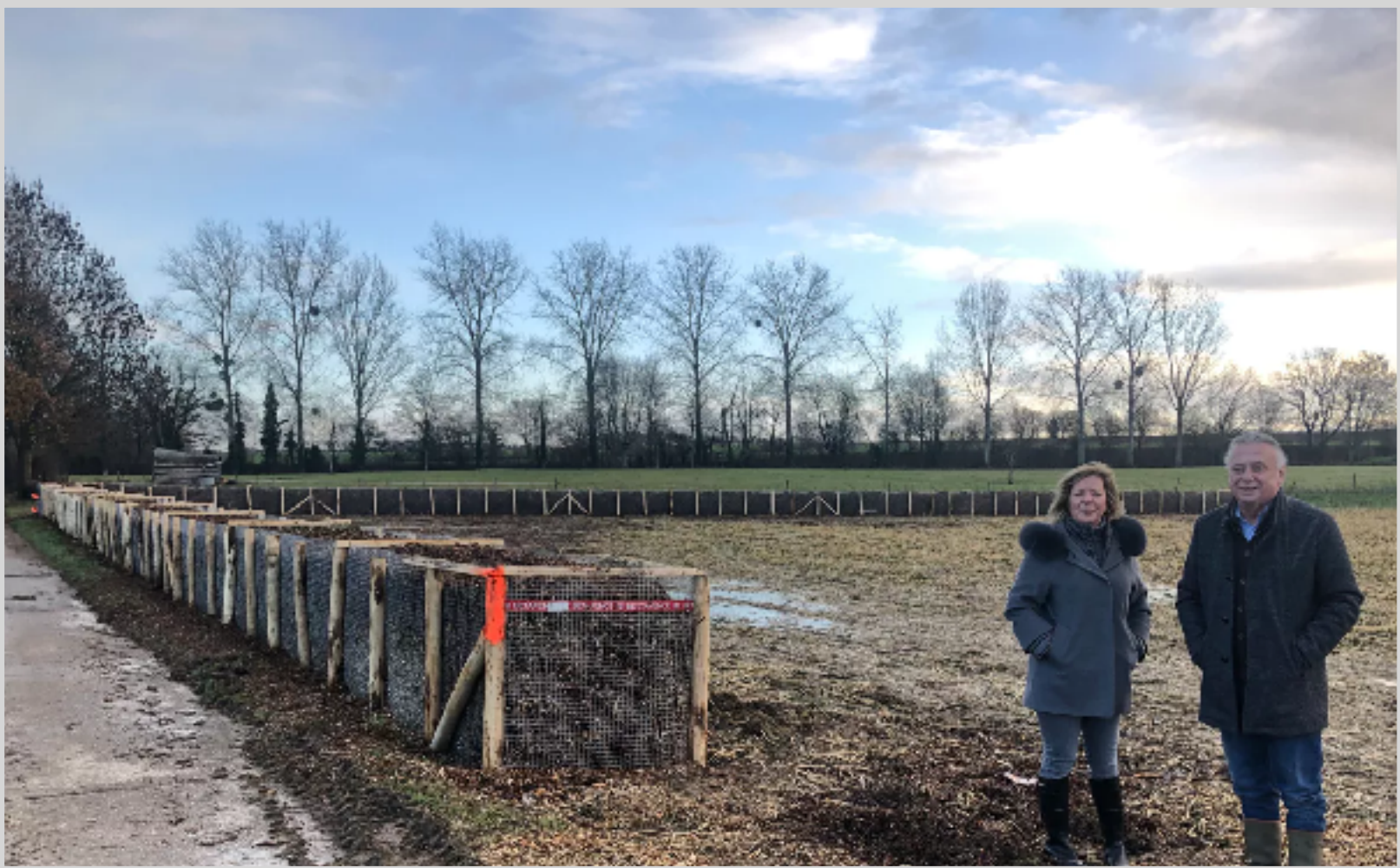
Aanleg van een erosiedam in Nerem (Tongeren)
